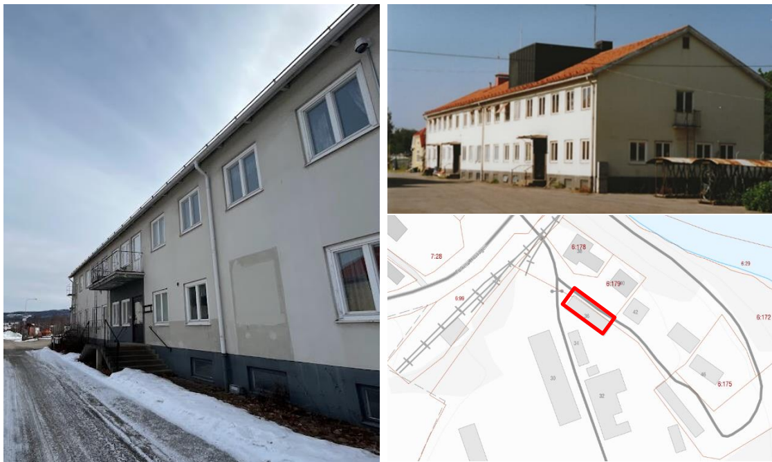
Byggnad som skyddas med varsamhetsbestämmelse [k 1 ] i planförslaget (Foto uppe till höger: Ulf Sundholm).
