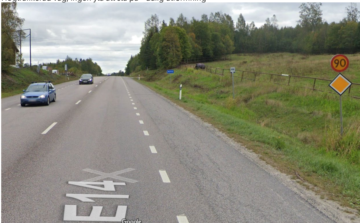
Berg E14, Sundsvall - 0,9 påstigande per dygn 2019 (hållplatsklass E) Högtrafikerad väg, ingen yta att stå på - dålig utformning
