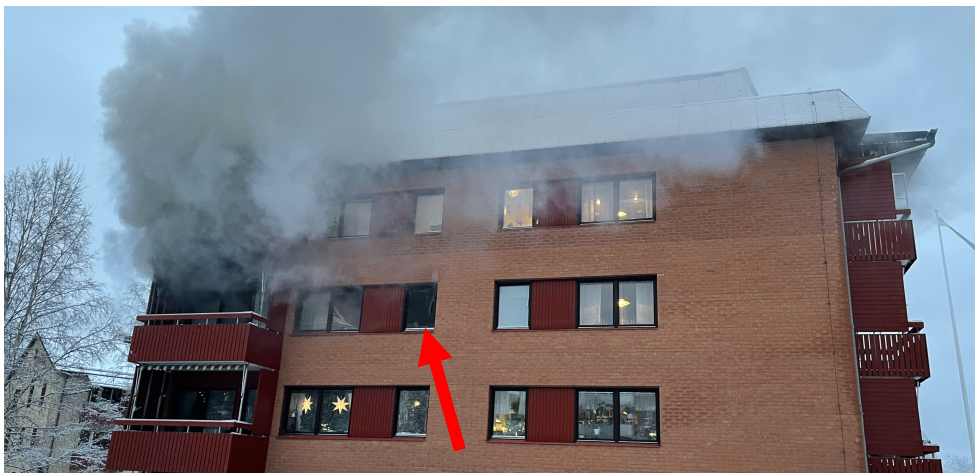
Bild 5 Bilden tagen klockan 08:45. Rök tänger ut från balkong, man kan ana att balkongdörren står lite öppen. Notera fönstret tillhörande köket (röd pil) som är svart av sot och har vissa skador i glaset.
