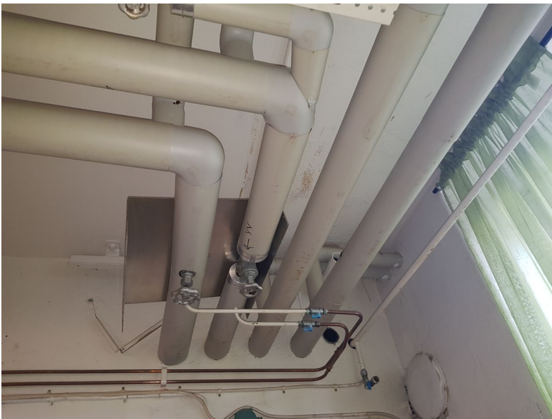
Senad, souterrängplan – Takläckage vid nederbörd. Provisorisk dropplåt monterad
