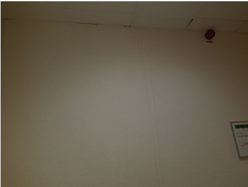
Kontorsmiljö, plan 1 – Korridor utanför pausrum, spår från fukt från innertak
