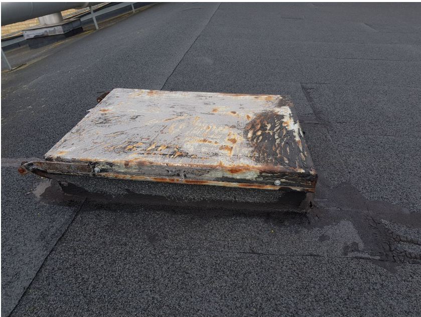
Ovan Gym, södra sidan - Utvändig inspektionslucka igenskruvad
