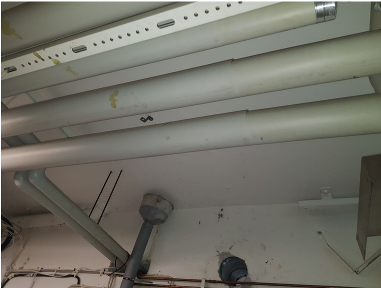
Senad, souterrängplan – Tratt med avloppsledning monterad provisoriskt för att ta hand om inläckande vatten
