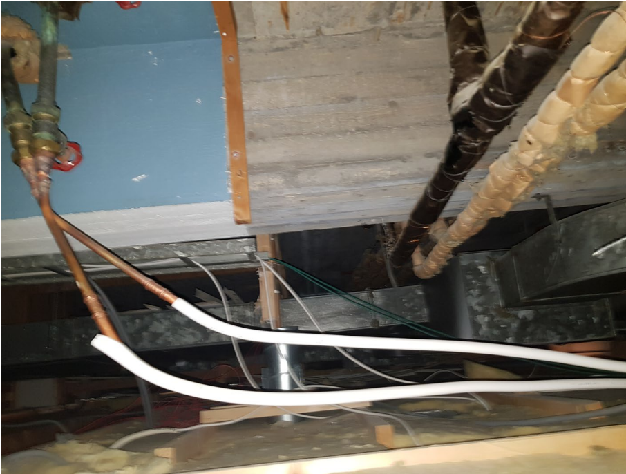
Bizmaker, plan 1 – Frånluft slutar i installationsutrymmet
