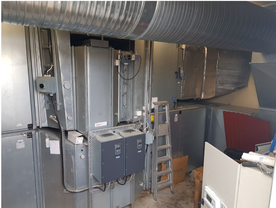
Yttertak, fläktrum beläget på yttertaket
