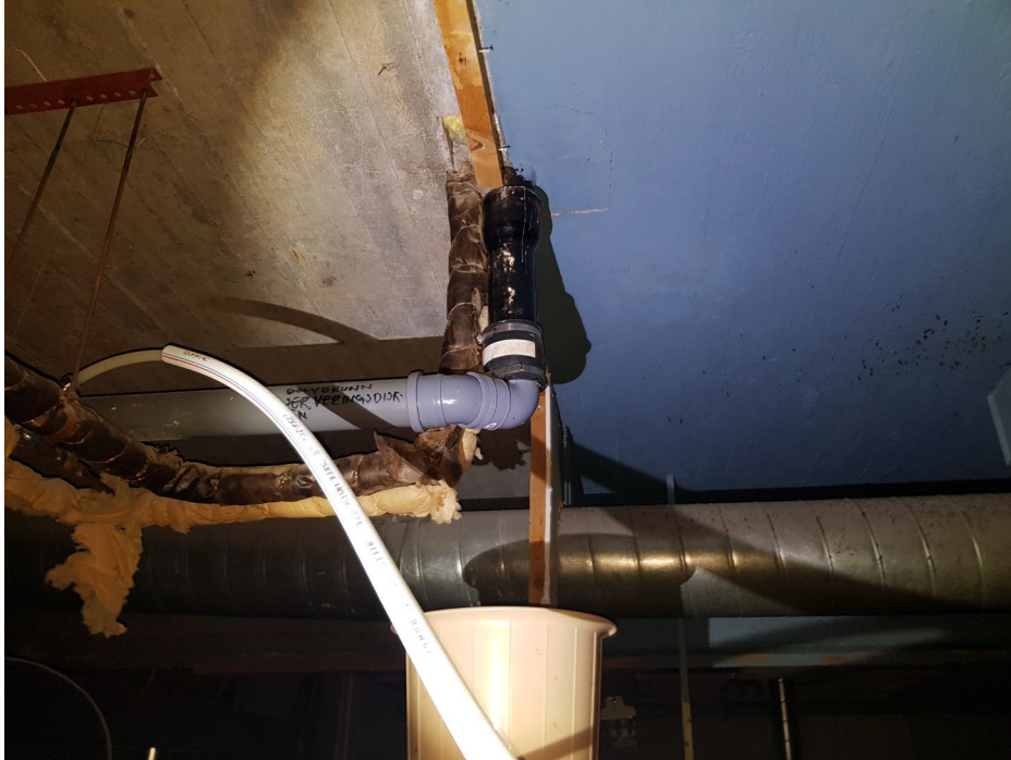
Bizmaker, plan 1 – Misstanke om avloppsläckage från plan 2
