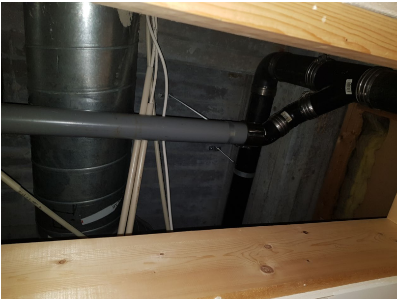
Kontorsmiljö, plan 1 – Utbytt del av avlopp ovan innertak
